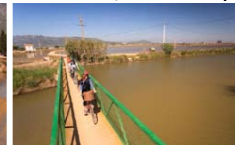
5 Puente de los Tres desagües
